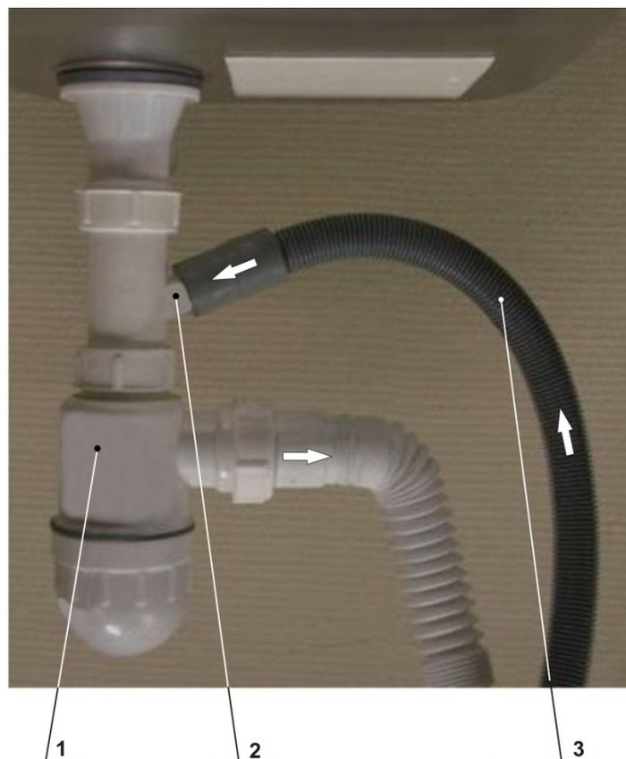
Рис 8. Подключение к канализации шланга для слива использованной воды.
